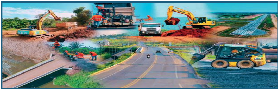
Imagem 10: Obras de Infraestrutura DER
